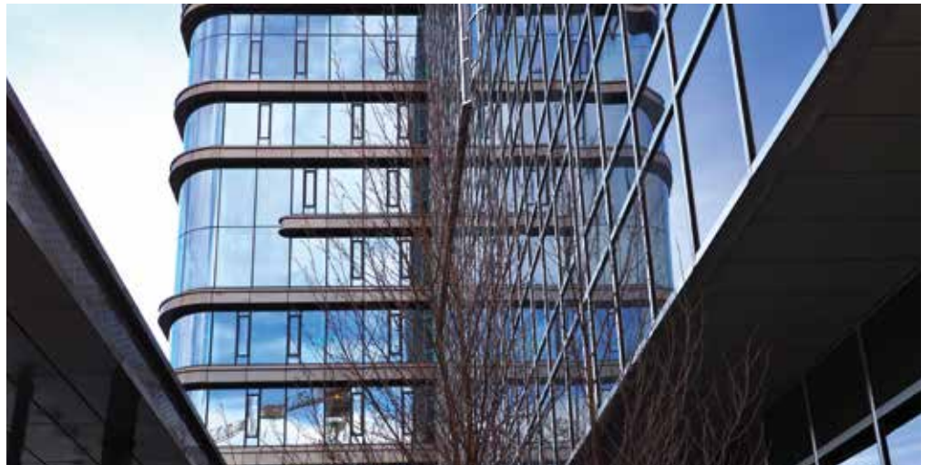
RENOVATIE & NIEUWBOUW ATRIUM - AMSTERDAM
